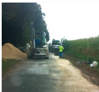
Pendant les travaux.
