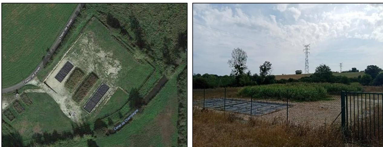
Photo 2 : Station de traitement de Champagne
