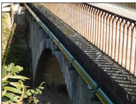
Photo 5 : Exemple de pose en encorbellement
