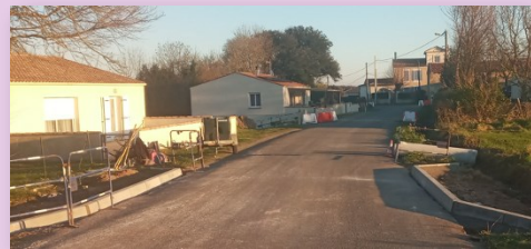
L'entrée haute de Razour pendant les travaux.
