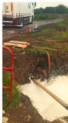
Vue de la 1 ère passe du forage dirigé.
