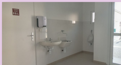
Entrée des toilettes publiques avec un urinoir, un lavabo et un bac pour l'agent de nettoyage.
