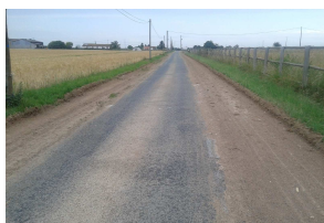
Dérasement des accotements.
