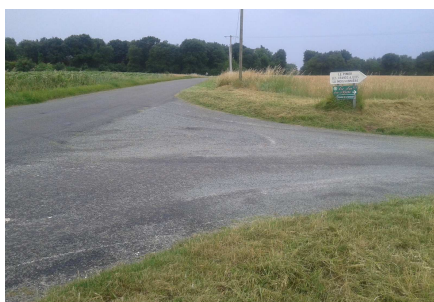
Bicouche sur les triangles préparés en février.
